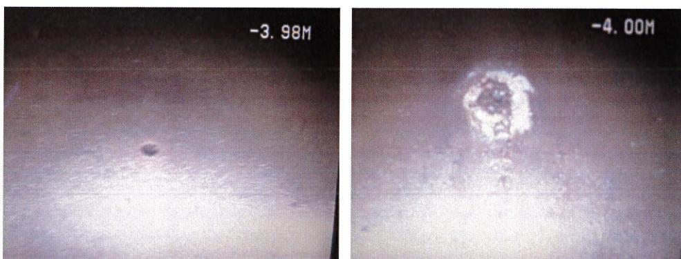
Figur 4.6 Skruehuller uden og med spor af vandindtrængning i 171.75
